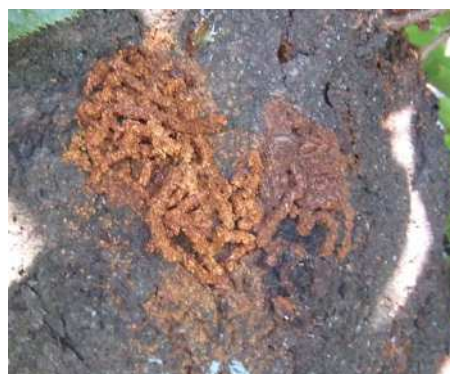
図2 食入孔から出たフラス
